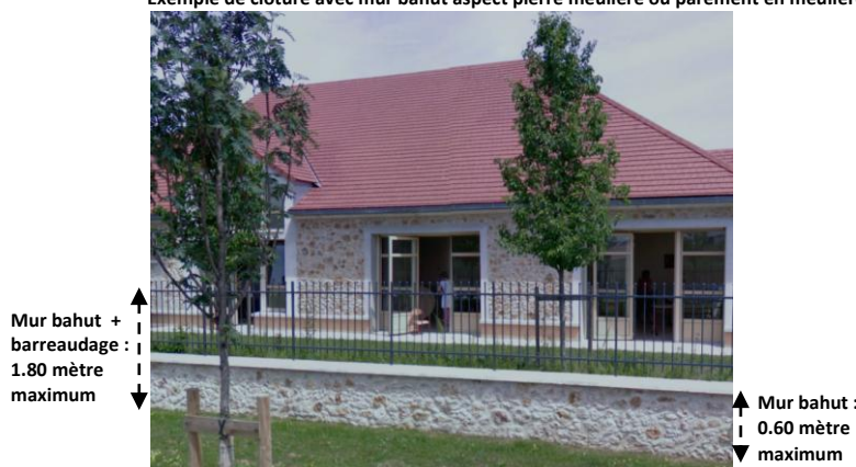
Exemple de clôture avec mur bahut aspect pierre meulière ou parement en meulière
